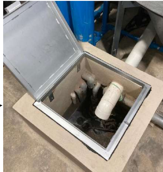
Cárcamo de bombeo al alcantarillado
